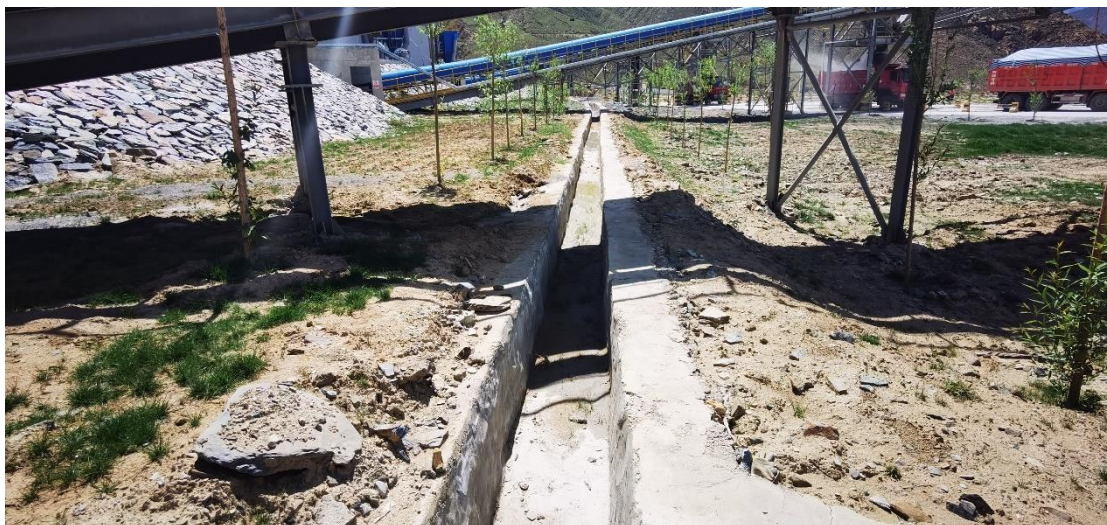
厂区栽植乔木绿化与排水沟
