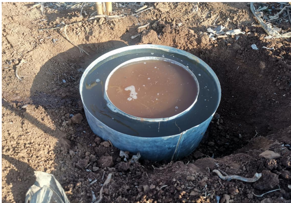
图 8.2- 现场渗水试验
