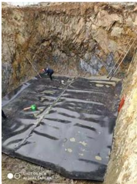
应急事故池防渗膜铺设
