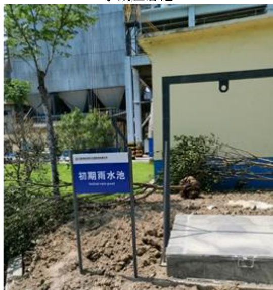
协同处置厂区初期雨水池
