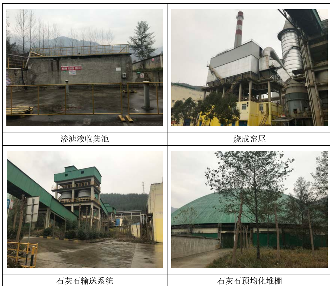
图 3-5 现场勘查照片
